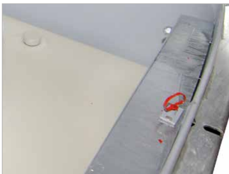
Peilstab für Leckagekontrolle
