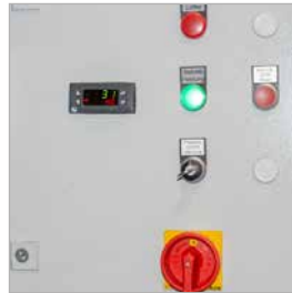
Schaltschrank mit digitaler Temperaturanzeige
